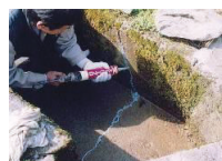
水路のひび割れ補修
