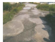
農道の窪みの補修
